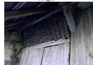
Détail de clayonnage pour aérer le fenil sous le toit. Chalet de la Charbonnière à Entrevernes - © Inventaire du Parc naturel régional du Massif des Bauges
