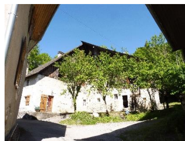
Gros corps de ferme au Bosson type chalet savoyard sur 2 niveaux se distinguant par les matériaux utilisés : soubassement en pierre (logis, étable), bois en partie haute occupée par la grange et le sens du faîtage qui n'est pas dans la plus grande dimension du bâti – Bluffy (Les Bossons)
