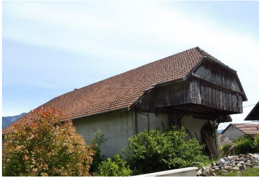
Forte avancée de toit sur le mur pignon augmentant la surface de stockage – ferme à Charvonnex (Doucy)
