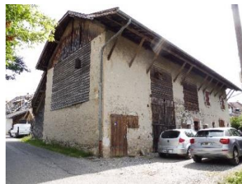
Ferme justaposée en moellons de calcaire avec bardage bois horizontal sur les murs pignon et gouttereau de la grange – Toit à pans cassés (coyaux) avec jambes de force – linteaux cintrés en brique - Annecy le Vieux - Frontenex (rue Jean Baud)
